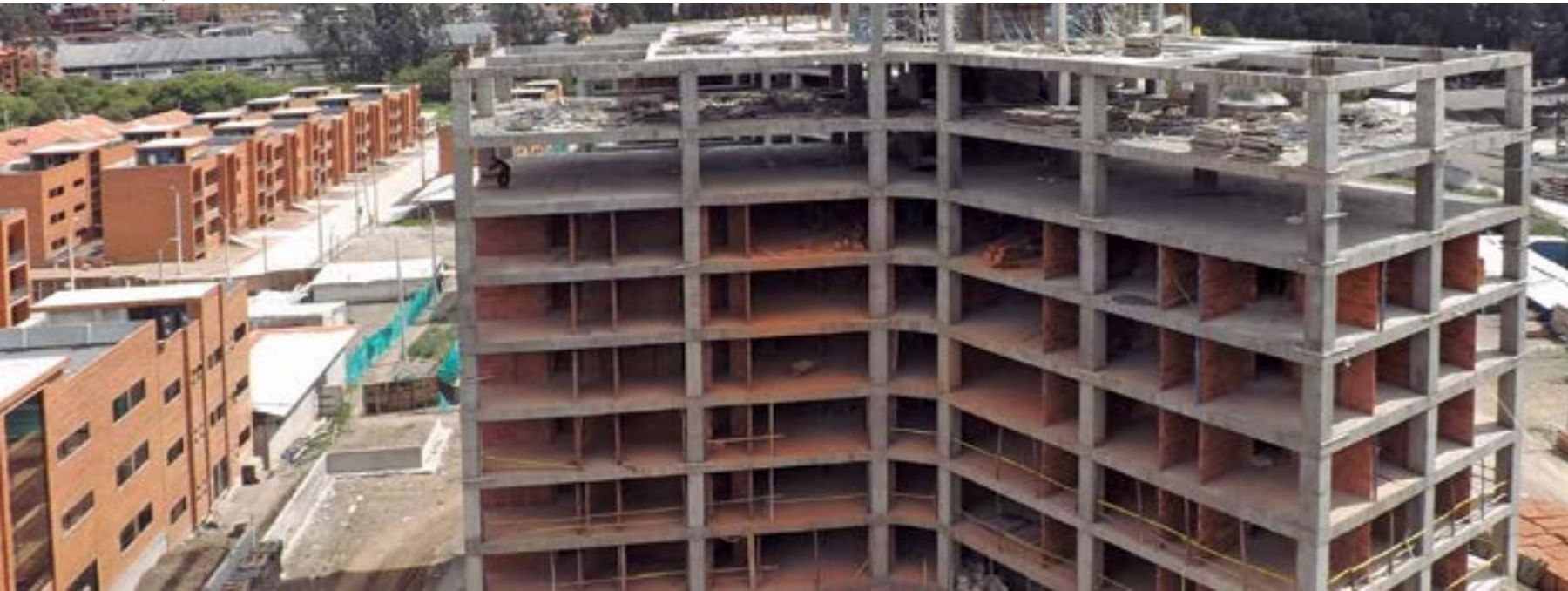
Avance de obras 2014
